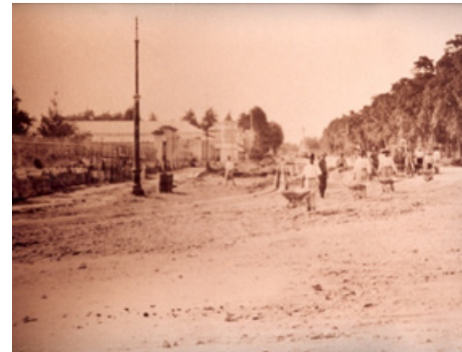
Fotografía 2. Trabajos de remodelación del Paseo La Reforma, probablemente entre 1920-1925. Nótese el pórtico y verja del Jardín Botánico. Archivo Jardín Botánico
